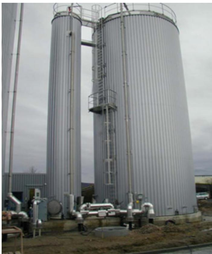
Neben dem Neubau der Anlagenteile Kompressorenstation und Pumpwerk auf dem Werksgelände einschl. Transportdruckleitung zur Kommunalkläranlage, dem Bau einer Vorbehandlungsanlage für Industrieabwasser in einer separaten Reinigungsstufe (mechanische Vorreinigung, Vorversäuerung und Anaerobreaktor) mit Abluftbehandlung und Gasverwertung, ist die Betriebsführung für vorerst 14 Jahre und die Finanzierung des Projektes als umfassende Dienstleistung inbegriffen.
